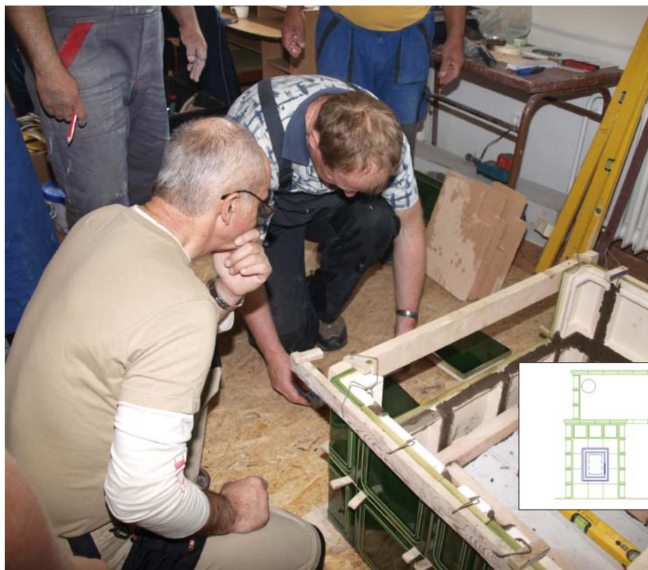
Součástí laboratoře jsou kachlová kamna. Jejich stavba se uskutečnila v rámci prvního odborného semináře konaného v dílně.
