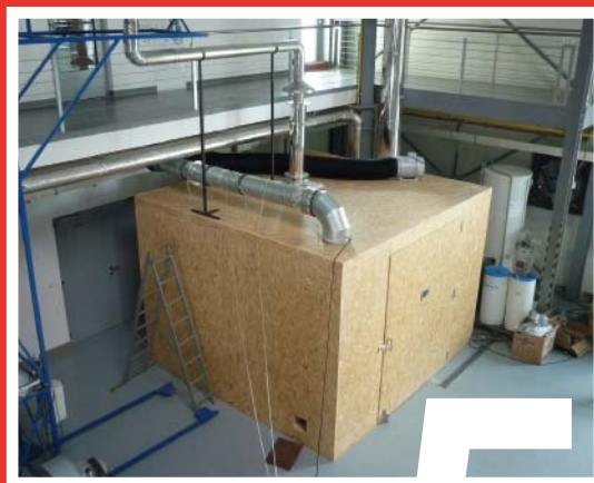
5 Celkový pohled na dokončenou kalorimetrickou místnost.
