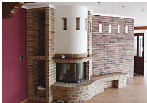
Tepl vzdušný krb s krbovou vložkou v cihlové obestavbě.
