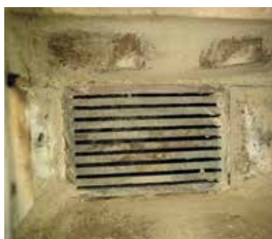
Po opravě spár
