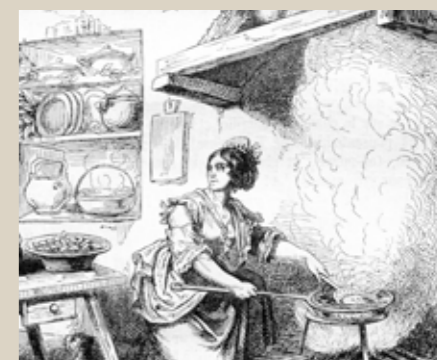
ČERNÁ KUCHYŇ otevřené ohniště uprostřed domu s komínovým odtahem, určené pro přípravu pokrmů vařením, grilováním nebo uzením.
