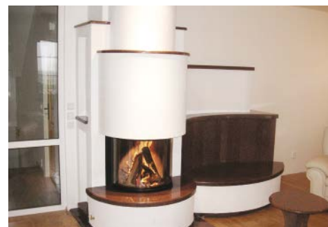
Akumulační sálový krb s krbovou vložkou a hypokaustem.
