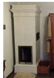
Sloupová kamna v ložnici mají zabudovaný systém, díky němuž mají majitelé vždy teplou vodu.
