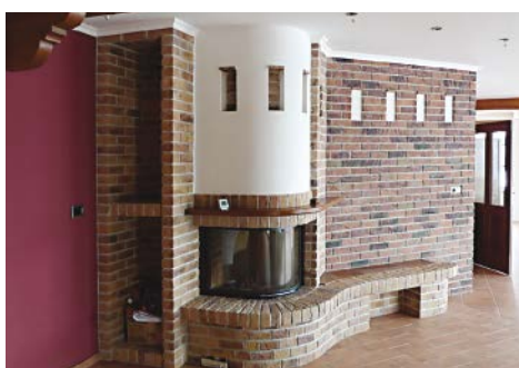
Teplovzdušný krb s krbovou vložkou v cihlové obestavbě.
