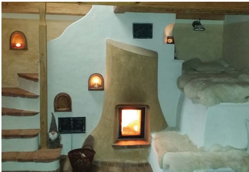
Největší místnosti ve stavení dominují akumulční kamna s vyhříváním ležením a schody vedoucími do podkrovní.
