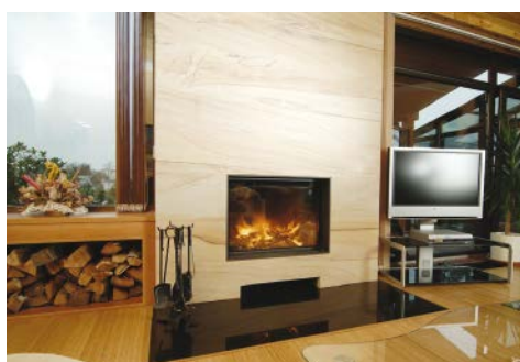
Teplovodní krb s velkou krbovou vložkou.
