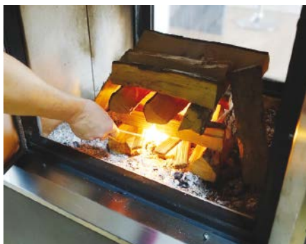
Správně vyskládaná dávka dřeva. Na podporu zatápění by se měly používat tuhé nebo tekuté podpalovače, nikoli noviny, které mohou zanášet spalinové cesty.
