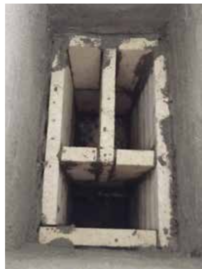
Nový třikomorový tah bez vzduchové mezery mezi tahy a kachli – podle původního řešení.
