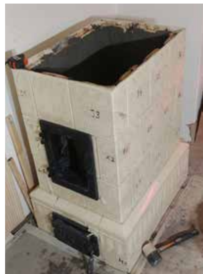
Stavba spodní části kamen s topeništěm a dvířky Jokr.
