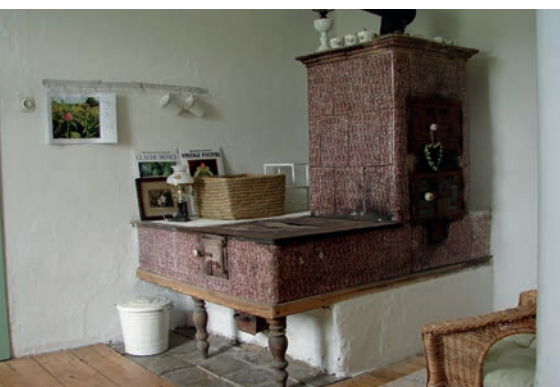
Kachlový sporák na dřevěném podstavci ze 70. let 19. století se samostatným roštovým topeništěm, součástí plotny je litinový kamnovec pro ohřev vody. Chalupa v Korouhvi.
