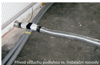
Přívod vzduchu podlahou vs. instalační rozvody
