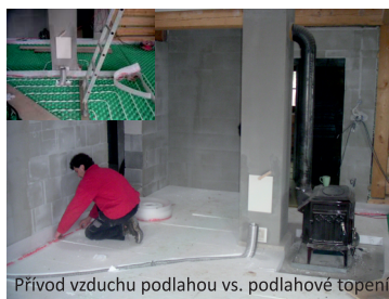
Přívod vzduchu podlahou vs. podlahové topení
